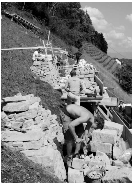
Bau der Trockensteinmauer im Hubschberg. (Foto: W. Schüpbach)
